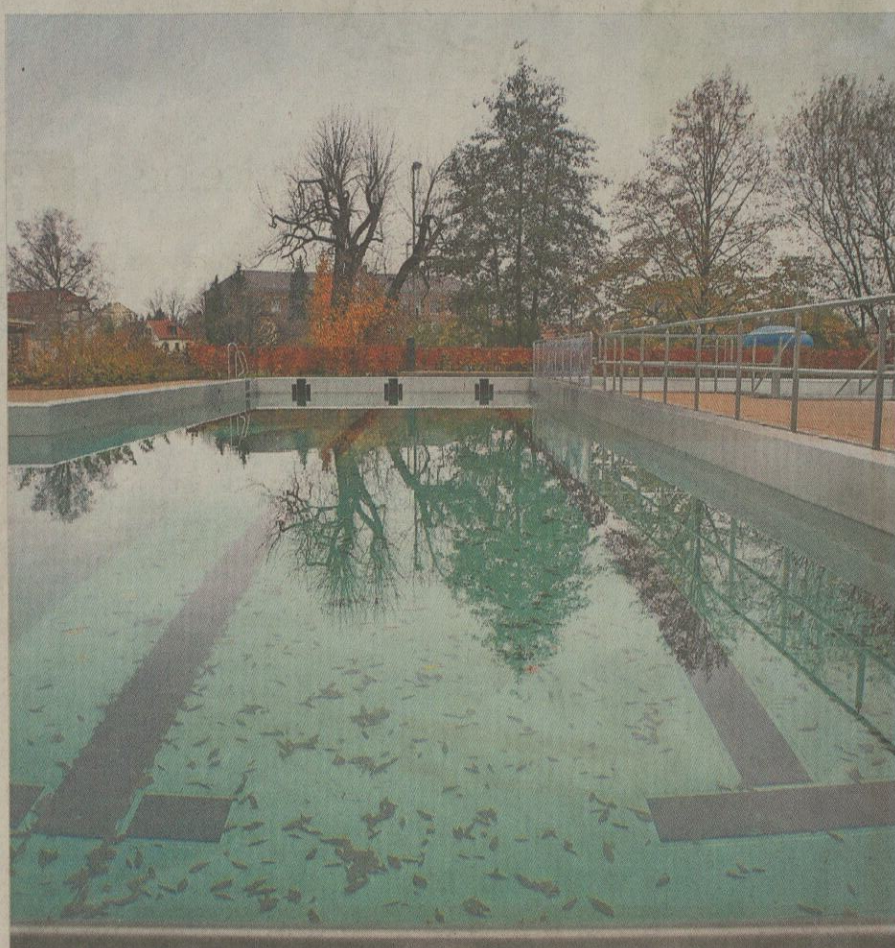
Die Ruhe im Hebbelbad täuscht. Auf den Liegewiesen wird derzeit eine Drainage verlegt, auch ein neuer Zaun steht schon. Die Lage des Edelstahlbeckens wird nächstes Jahr kontrolliert.
