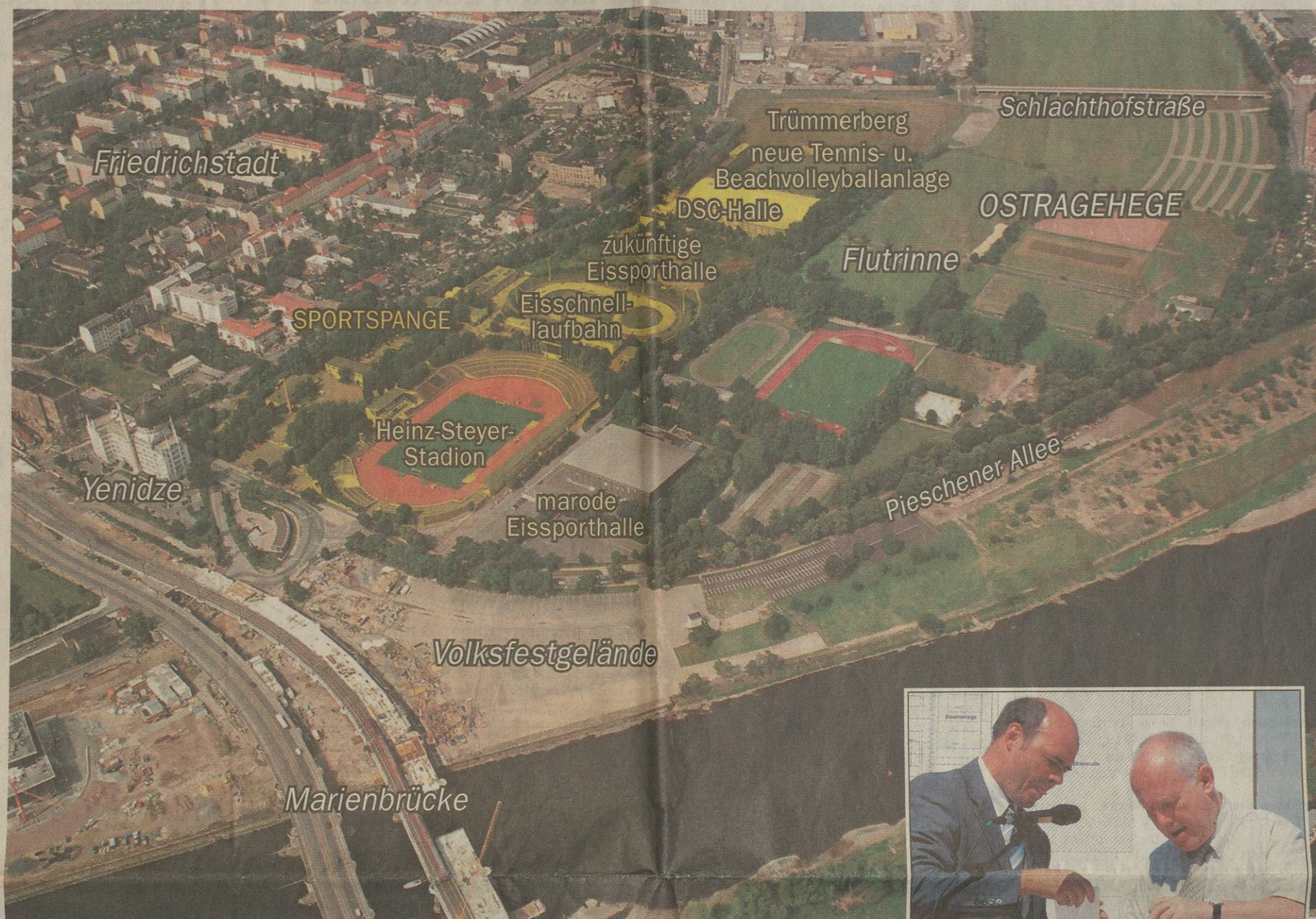
Zwischen DSC-Halle und Trümmerberg entsteht bis Mai 2005 eine neue Tennis- und Beachvolleyballanlage. Am Freitag war Grundsteinlegung im Beisein von Ministerpräsident Milbradt (rechts) und Sportamtschef Raphael Beckmann. Anfang 2005 soll Baustart für die Eissporthalle und das Sportschulsportzentrum sein. Fotos: Lufbild 2003 Archiv/Günther
