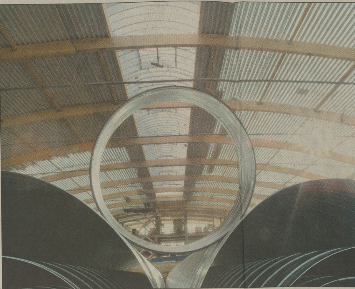
Schon ein geschlossenes Dach hat die zukünftige DSC-Trainingshalle an der Pieschener Allee.
