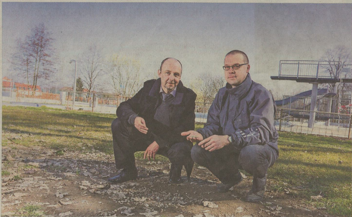
Bäderchef Matthias Waurick (links) und Architekt Hendrik Baar wissen, dass bei der Modernisierung des Freibades Cotta einige Fehler passiert sind. Die Versäumnisse sollen aber erst nach der Saison ab Herbst nachgeholt werden.
