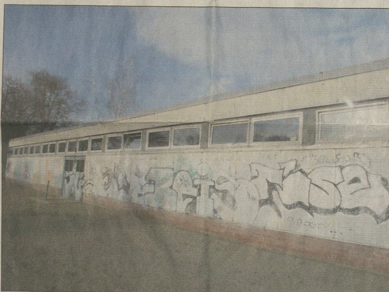
Die Sporthalle der 108. Grundschule ist beschmiert. Innen sind Toiletten und Umkleieräume in einem schlechten Zustand und müssen erneuert werden.
